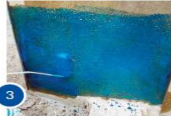
3 На усиливаемую поверхность наносится первый слой клея.
