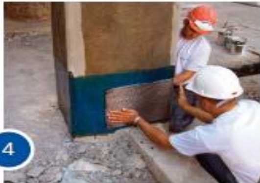
4 Холст укладывается и прокатывается резиновым валиком.
