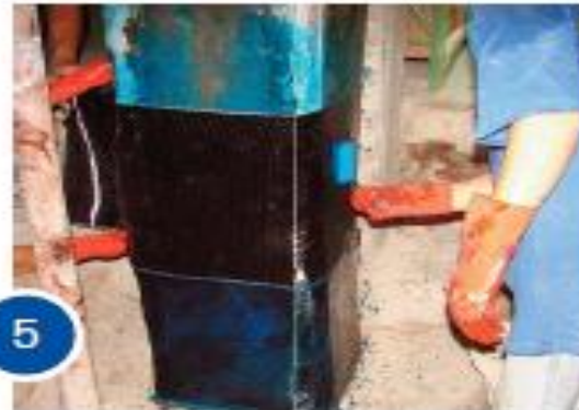
5 На поверхность холста наносится второй слой клея.
