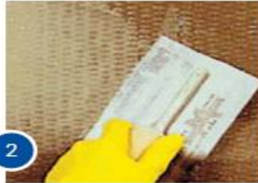
2 Выравнивающий раствор наносится пока грунтовка еще липкая.
