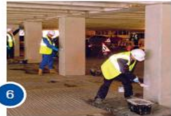
6 После отверждения наносится защитное покрытие.
