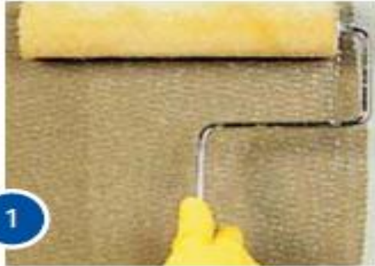
1 Прочность сцепления повышается благодаря нанесению праймера.
